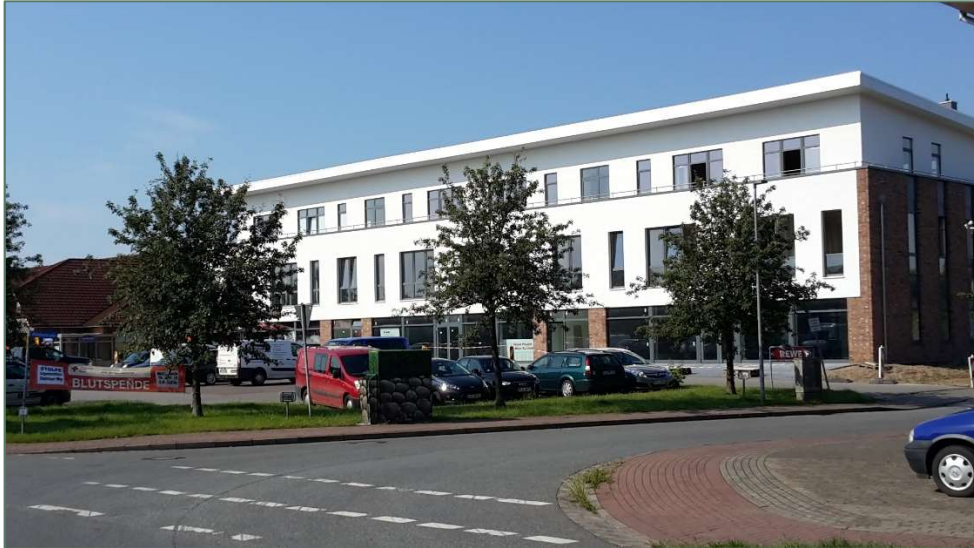
Abbildung 35: 2018 errichteter Neubau mit Flächen für Dienstleistungen, Einzelhandel; Bornhöveder Landstraße
