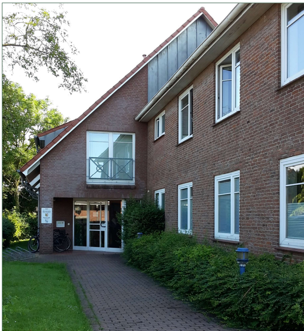
Abbildung 6: Gebäude der Amtsverwaltung, Haupteingang
